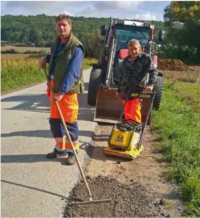
Heinz Winkler und Johann Zwettler sanieren das Straßenbankett in der Doberndorfer-Straße nach den Starkregenereignissen.
